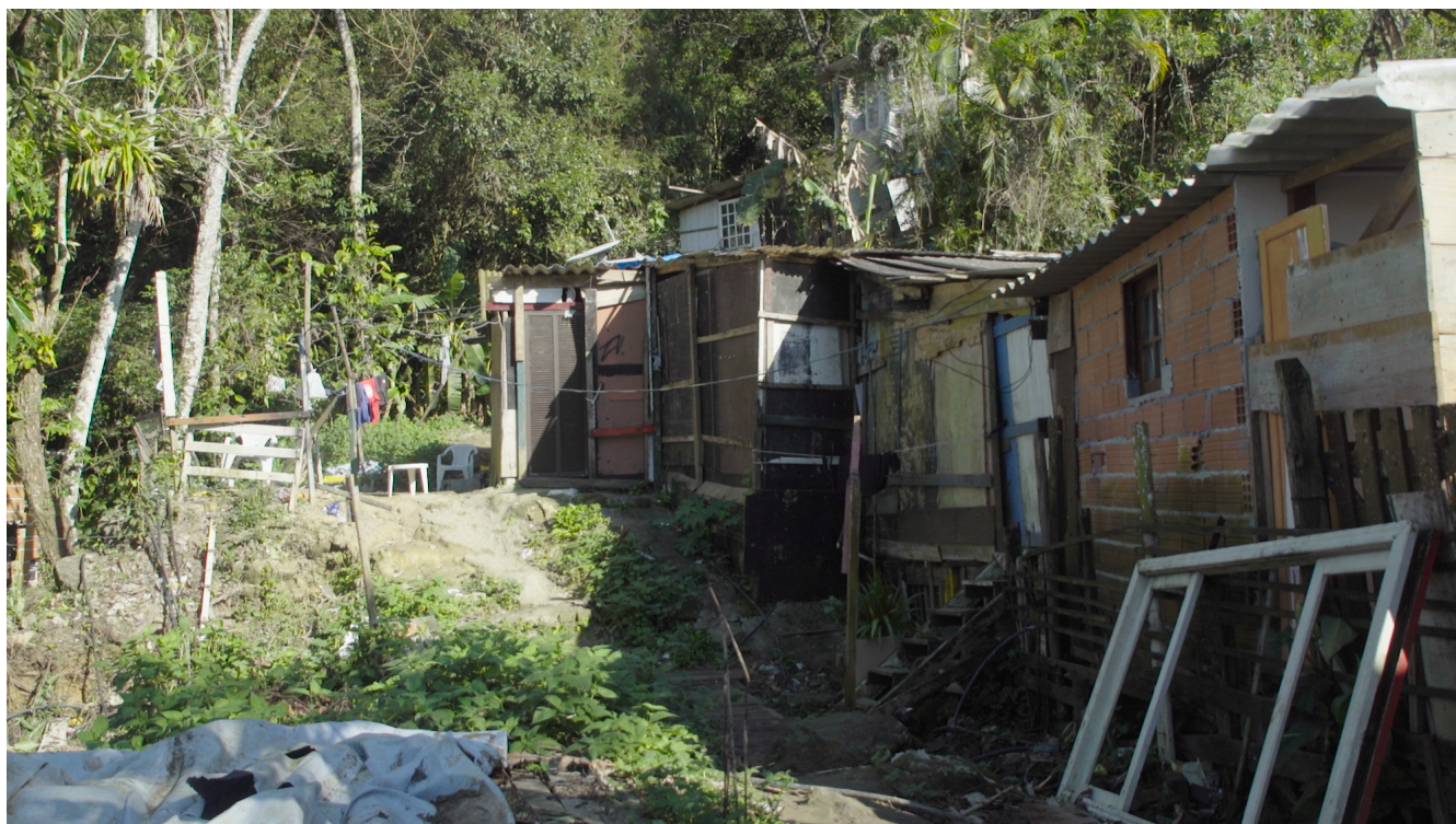
Moradias em risco no Morro do Esquimó/Foto: Ed Davis
