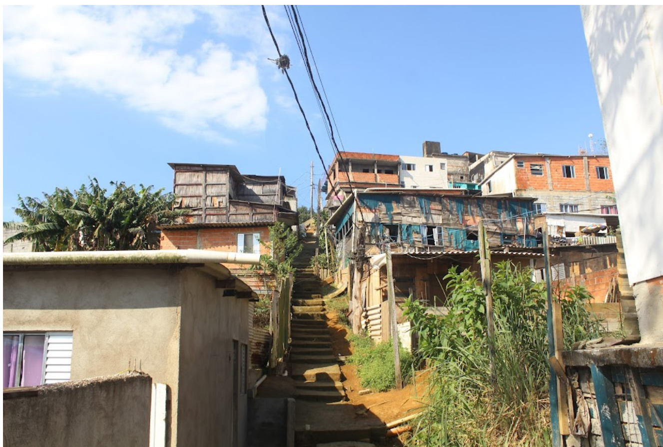
Escadaria e moradias na Ocupação Bela Vista/Foto: Ailton Martins
